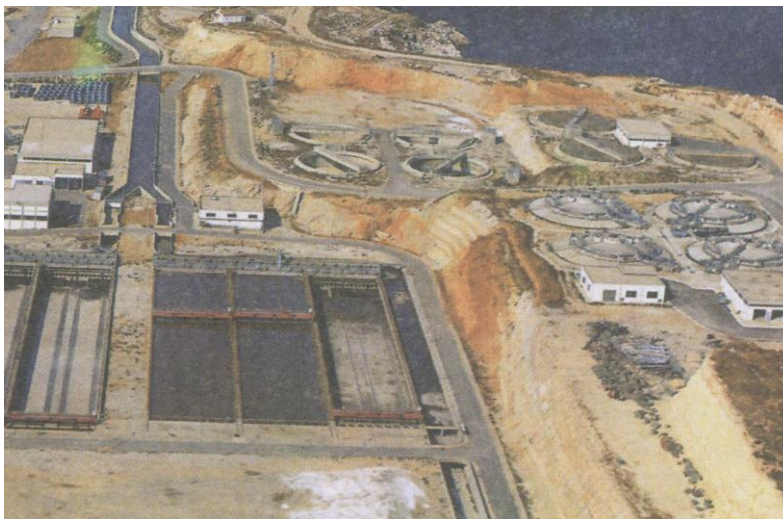
Εγκαταστάσεις βιολογικού καθαρισμού στην Ψυττάλεια.
